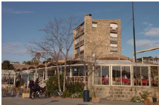
Hameau des Sablettes - La Seyne-sur-Mer (source : service communication de la ville de la Seyne-sur-Mer)
