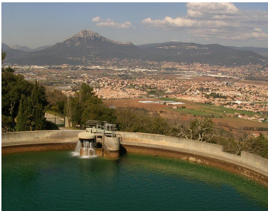
Bassin de la SCP du Fenouillet
